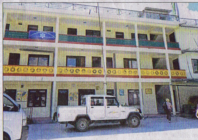
L'école des Amchis est désormais fissurée et des travaux sont urgents.
